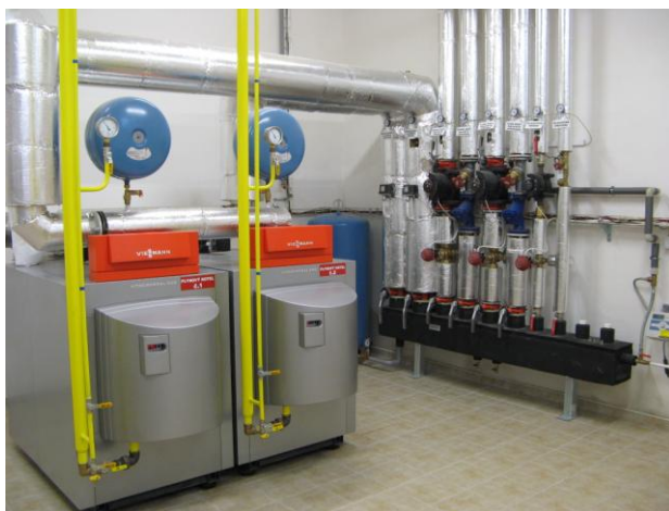
Nová kotelna v budově GVM. Foto: Pavel Dvořák.
