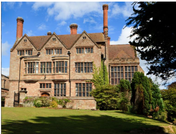
Hlavní budova ADCOTE SCHOOL v Shrewsbury
